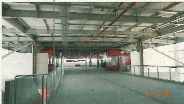
Foto 13 – Vista do lado leste do Mezanino.
