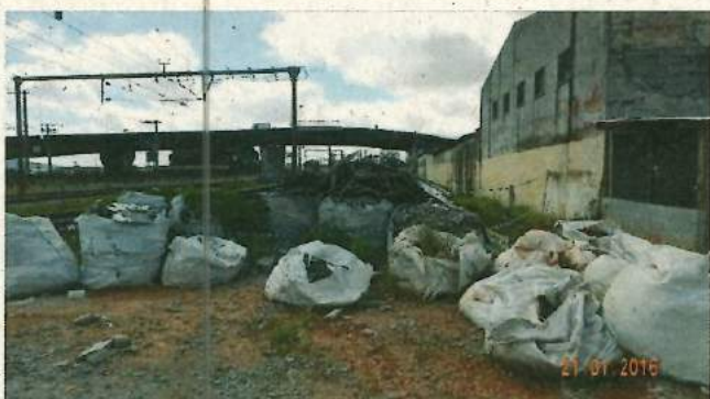
Foto 31 – Disposição de resíduos de amianto, também aguardando destinação final.
