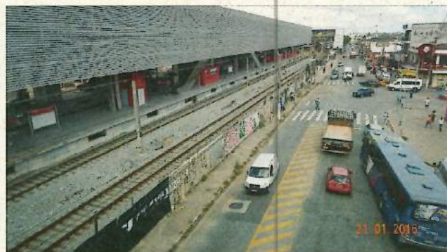
Foto 24 – Fachada da estação junto à Av. Jorge Bei Maluf.
