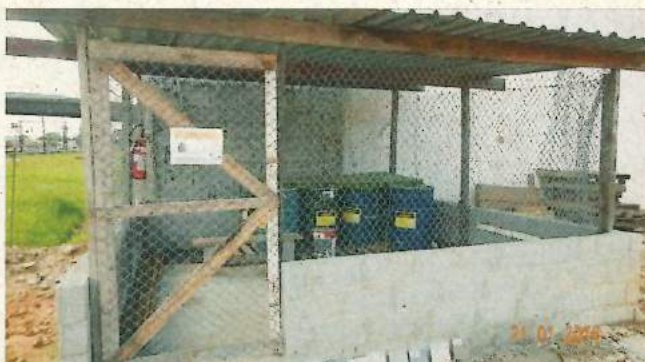
Foto 34 – Baía de armazenamento do material contaminado.
