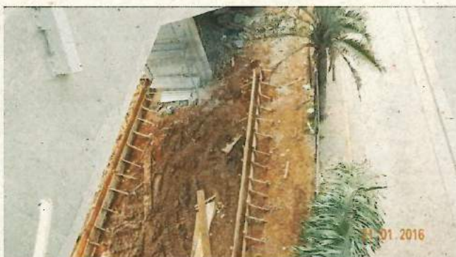
Foto 23 – Formas para execução das bases para os gradis de fechamento da área sob o acesso.
