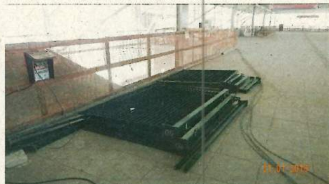
Foto 12 – Detalhe dos gradis a serem instalados para delimitação da área operacional no Mezanino.
