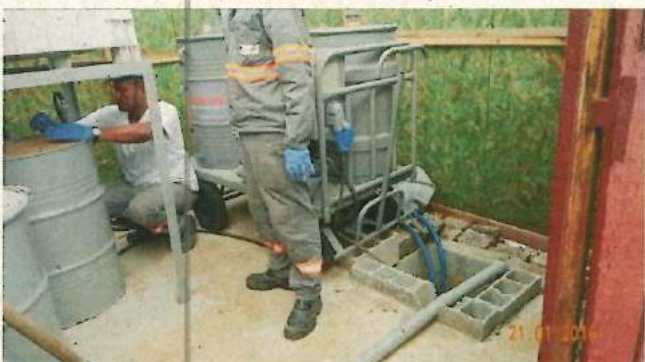
Foto 33 – Equipamentos para remoção da fase livre da área contaminada.
