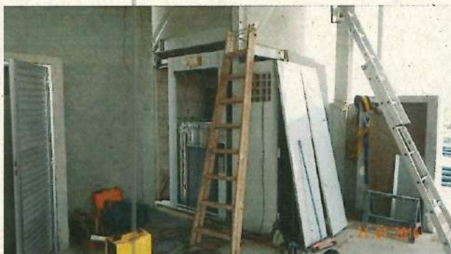
Fotos 19 e 20 – Instalação do elevador e da escada rolante.
