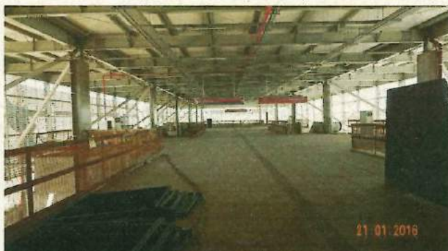
Foto 11 – Lado oeste do Mezanino, que também não estará em operação nesta fase.
