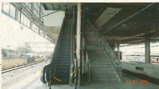
Foto 7 – Detalhe das escadas rolante e fixa da Plataforma Norte.
