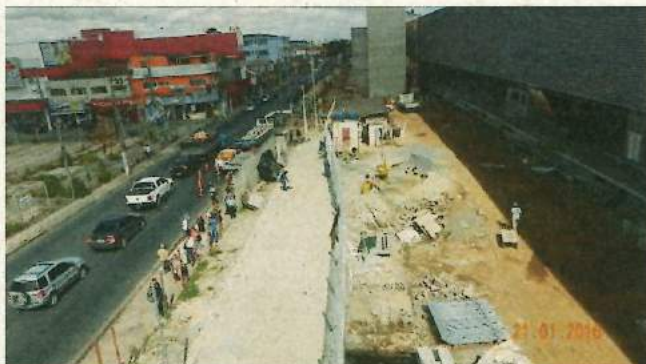
Foto 27 – Vista da área entre a Plataforma Sul e a Rua Dr. Prudente de Moraes. Segundo informado, um novo calçamento está sendo executado e o antigo será pavimentado e convertido em baias para parada de ônibus pela Prefeitura Municipal.
