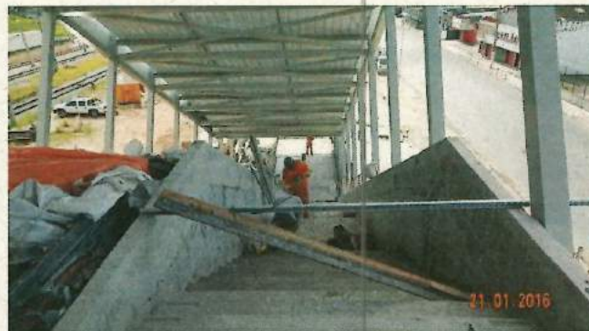
Foto 26 – Finalização da escada fixa e instalação da escada rolante.
