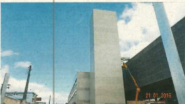
Foto 35 – Reservatório de água potável e prédio de apoio.
