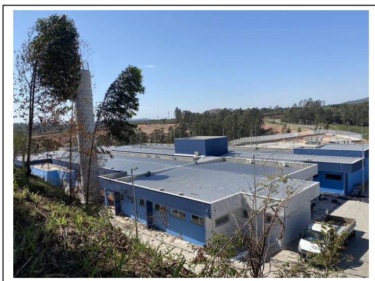
Foto 5 – Reforma da Cobertura
