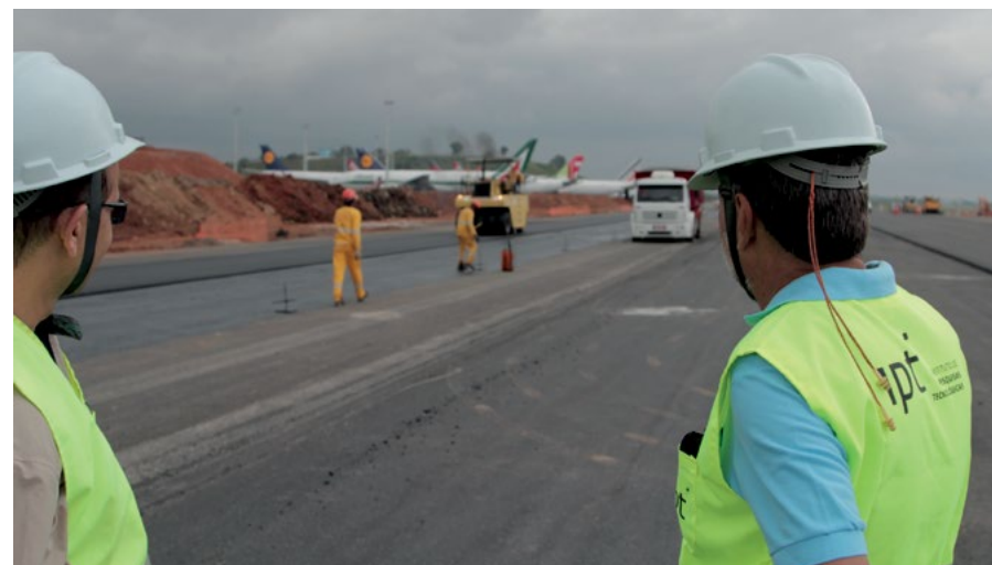
Inspeções de obras de pavimentação no Aeroporto Cumbica em Guarulhos
