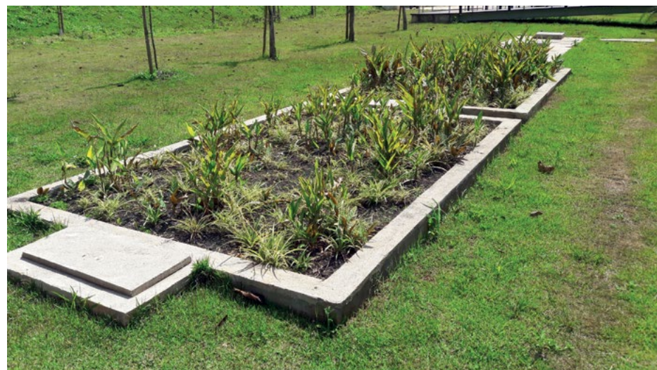
Alagados construídos (wetlands), para purificação das águas pluviais e a promoção da retenção de contaminantes são exemplos de tipologias funcionais de infraestrutura verde
