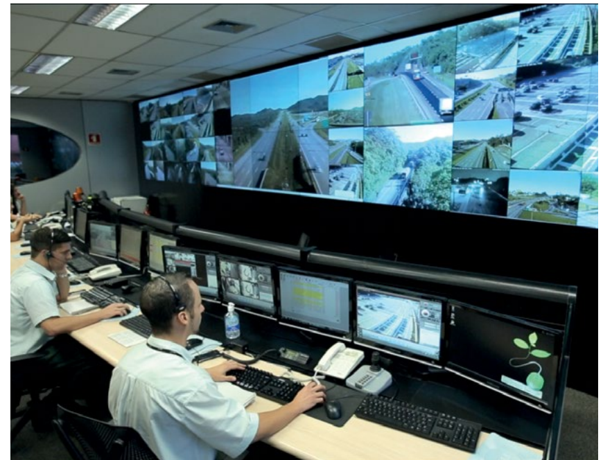
Cabine de controle da Ecovias para monitoramento das rodovias do estado de São Paulo
