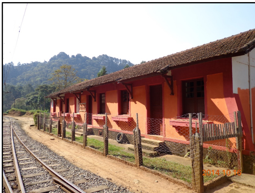
Foto 2: Conjunto de 3 casas nº 76, 77 e 78 – Área de 55,00m²
