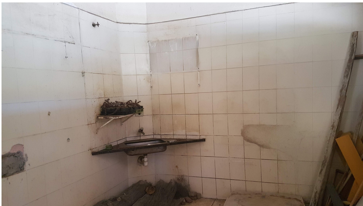
Figura 5 – Área interna da Copa
