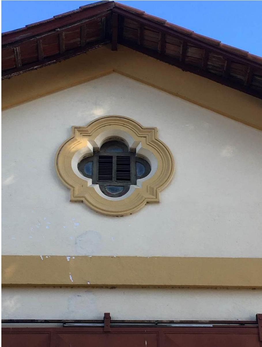
Figura 5 - Detalhe Janela a ser substituída na fachada
